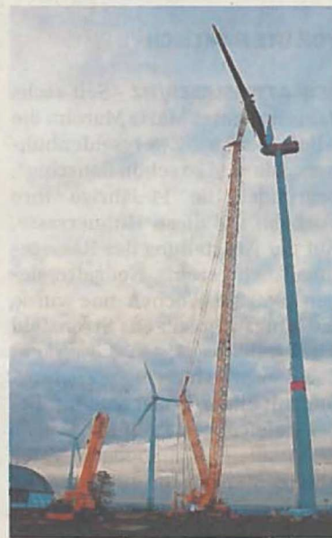
Das Windrad wird aufgebaut.
