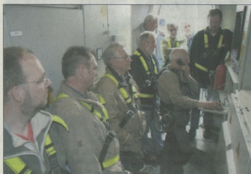
Im Eingangsbereich informieren sich die Exkursionsteilnehmer inmitten von Schalttafeln und Hightech-Geräten über die Funktionsweise der Windkraftanlage.
