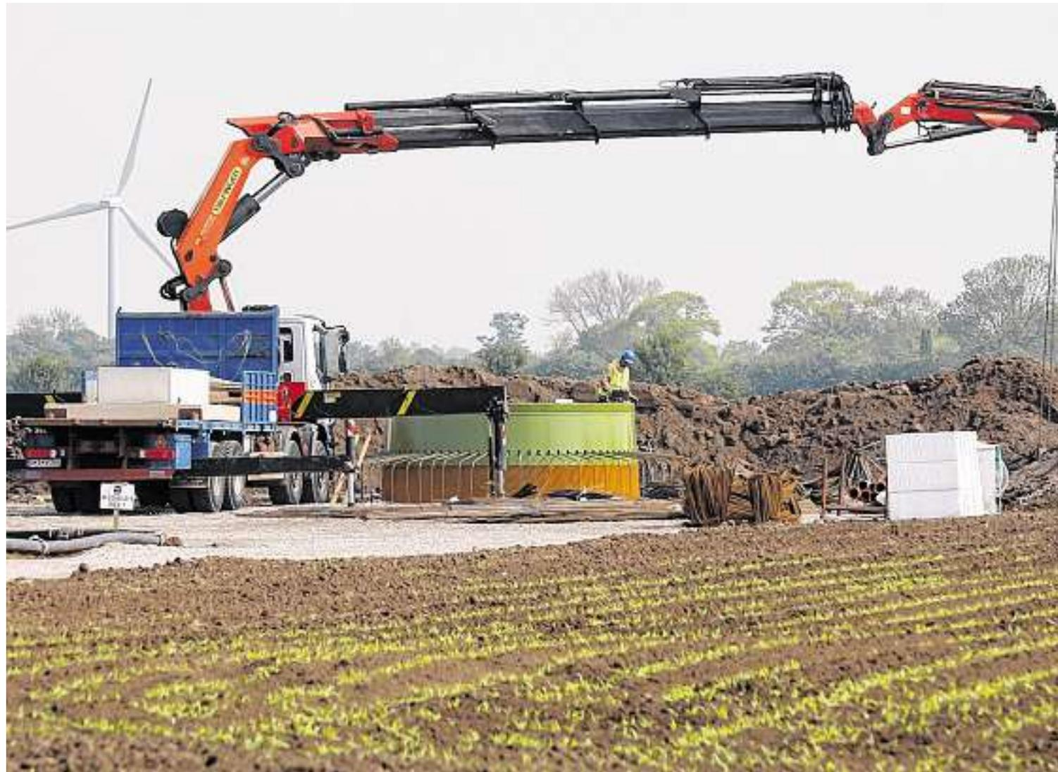
Baustelle im Beppener Bruch in Thedinghausen: Die vorbereitenden Tiefbauarbeiten fanden bereits im April statt, seit heute wird das Fundament betoniert. Montage und Inbetriebnahme beginnen Ende Juli und dauern voraussichtlich bis Ende August. FOTO: STRANGMANN
