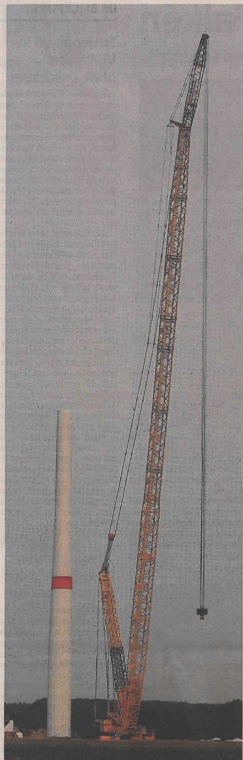
Die dritte Anlage steht kurz vor der Fertigstellung. Das Maschinenhaus wird dafür in die Nebenhöhe von 149 Metern gehievt. Der Kran hat die Höhe von rund 160 Metern.
