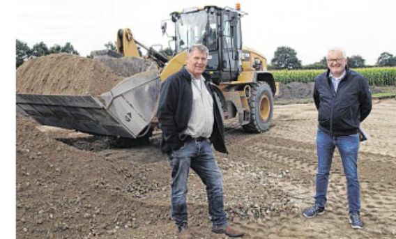
Startschuss für die Erschließungsarbeiten: Aukrugs Bürgermeister Jochen Rehder und „WindStrom“-Geschäftsführer Joachim Mrotzek (rechts). FOTO: H.-J. KÜHL
