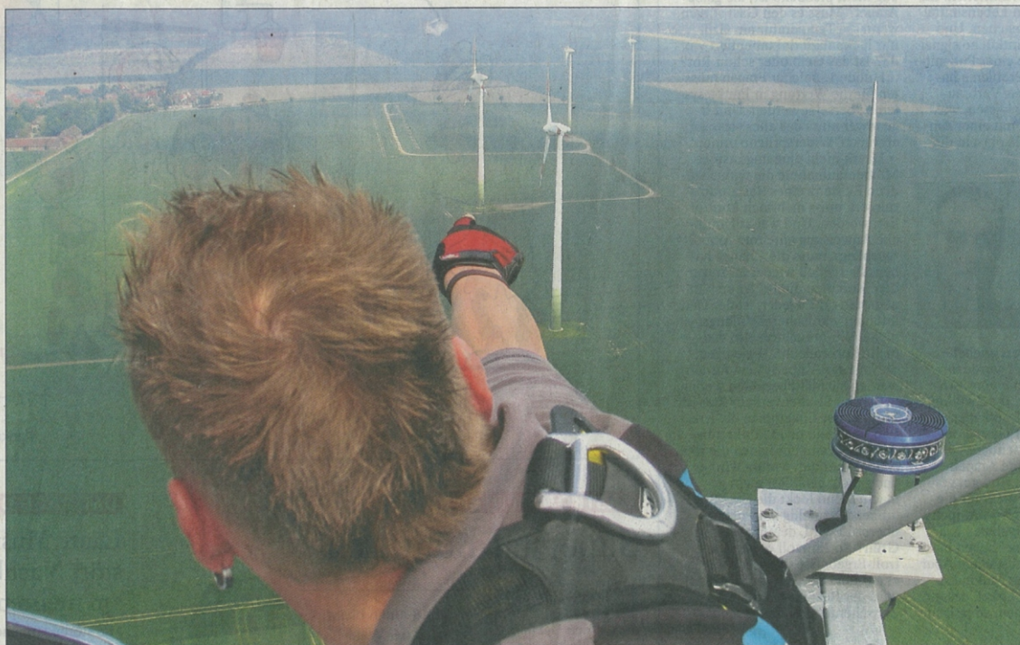
Blick vom 138 Meter hohen Windrad in Salzgitter-Lebenstedt: Swen Preisigke, Techniker der Firma Windstrom, erklärt die Anlagen im größten Windpark unserer Region, der den jährlichen Strombedarf von 22 000 Haushalten deckt. Foto: Katrin Teschner
