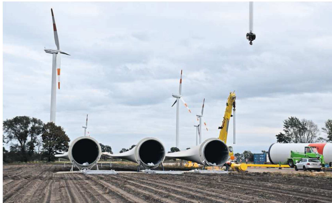
Nordöstlich von Uetze lässt die Firma Windstrom zwei 180 Meter hohe Windräder errichten. Im Vordergrund liegen die drei Rotorblätter für die Installation bereit.
