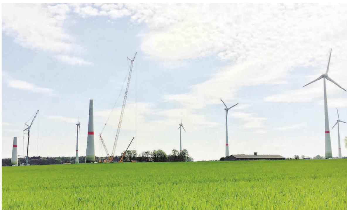
Zuwachs für den Windpark Winkelsett-Spradau. Derzeit werden sechs neue Anlagen errichtet.
