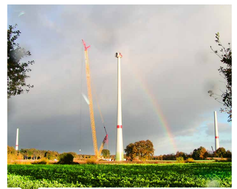
Mit Hochdruck wird am Windpark Spahnharrenstätte gearbeitet – Ende 2016 sollen alle Windenergieanlagen am Netz sein
