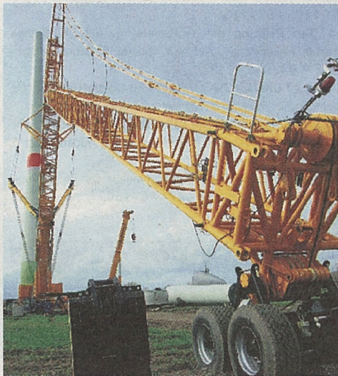
Das letzte der fünf neuen Windräder im Schwarmer Bruch wird gerade montiert. FOTO: BÖDEKER
