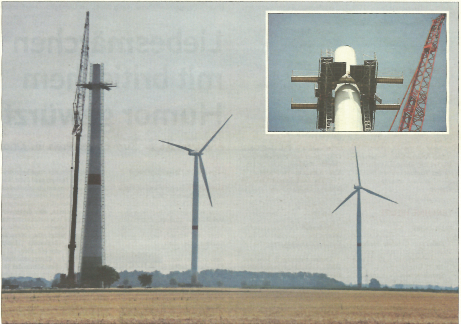
Hoch hinaus: Nördlich von Sievershausen entstehen vier neue Windräder. Zwei davon ersetzen alte Anlagen, zwei haben samt Rotor jeweils eine Höhe von 150 Metern. Die Monteure arbeiten in luftiger Höhe (kleines Bild). Gückel (2)
